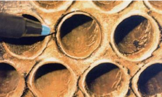
틈새 부식 (Crevice Corrosion)
