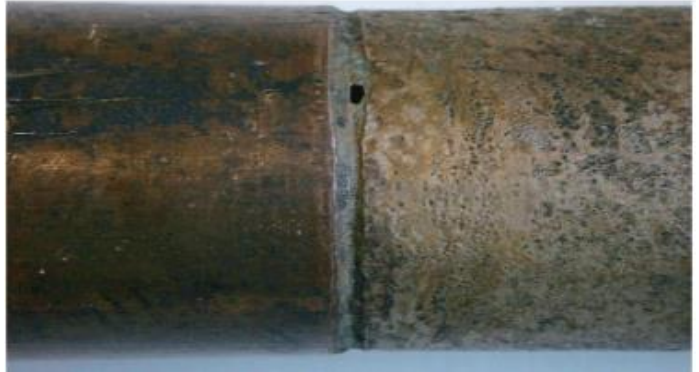
응력 부식 (Stress Corrosion Cracking)
