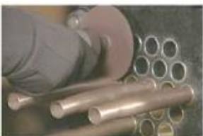
• Liner 끝단 부 절단
