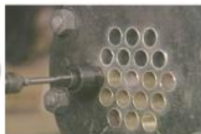
• 기계적 확관 작업
